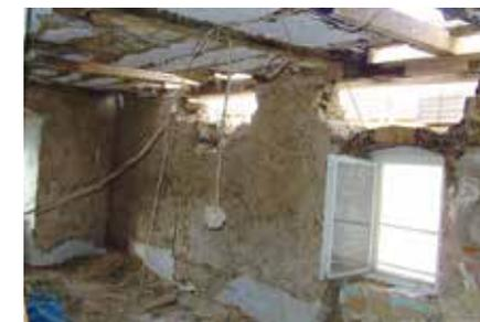
Betonboden, Wand- und Deckenverkleidungen aus den 50er Jahren wurden entfernt. Rückstände von einem Brand Ende des 19. Jhd. kamen zum Vorschein. Deckenbalken und Fußpfetten mussten repariert werden. Fensteröffnungen wurden geschaffen/vergrößert.
